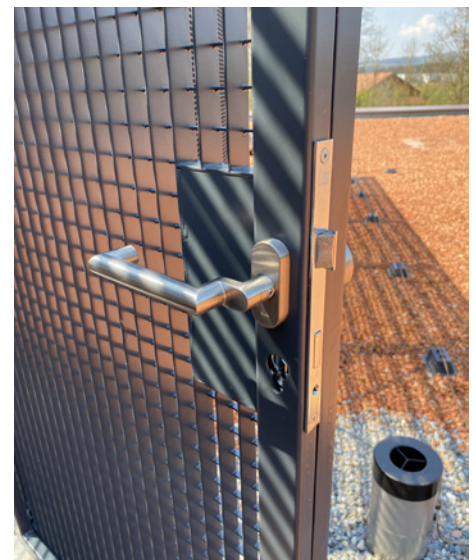
Ein Schlosskasten aus Blech ist im Pressrost eingeschweisst.
