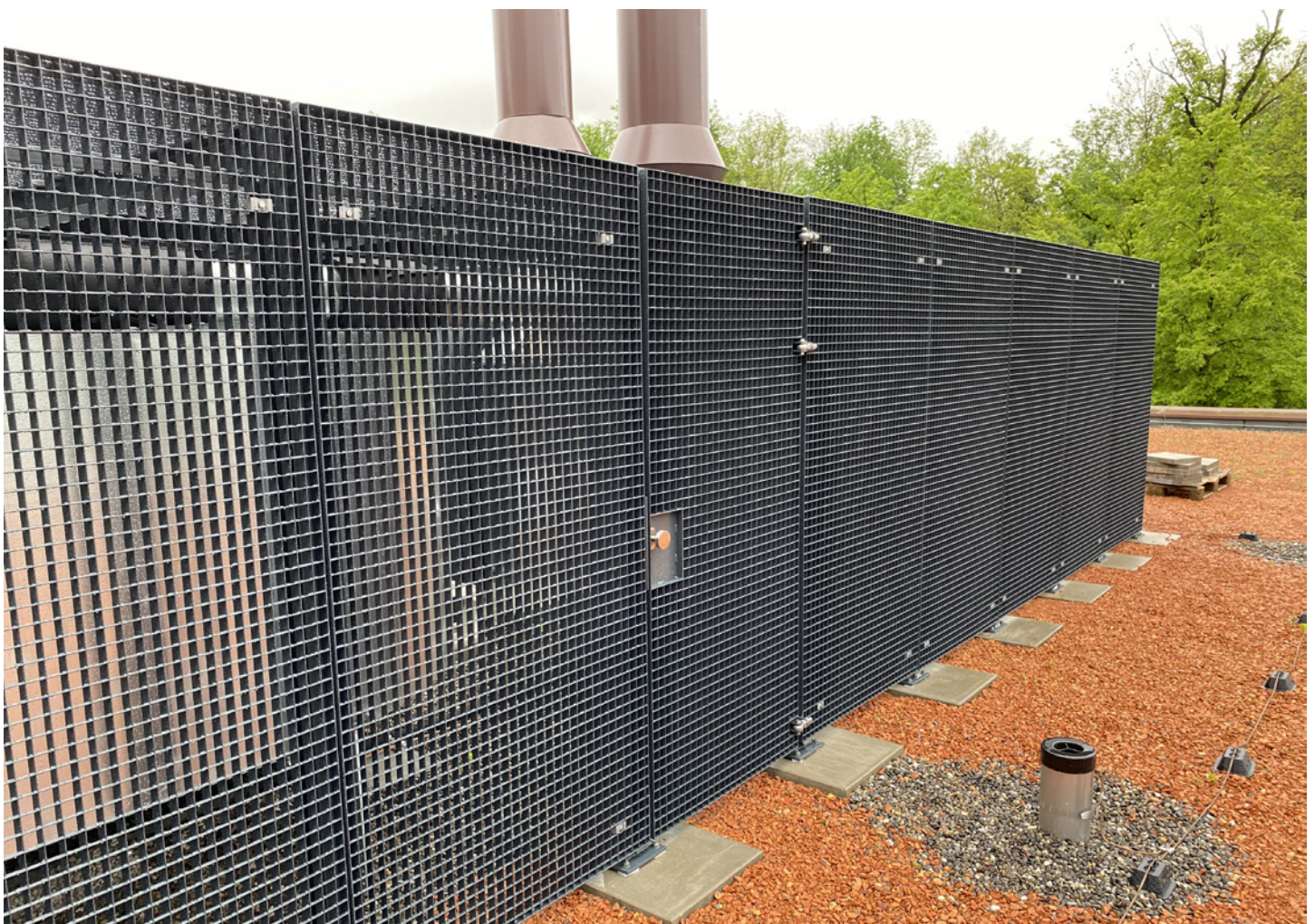
Pressroste eignen sich bestens für die Einkleidung von Heiz-, Lüftungs- und Rückkühlanlagen.
